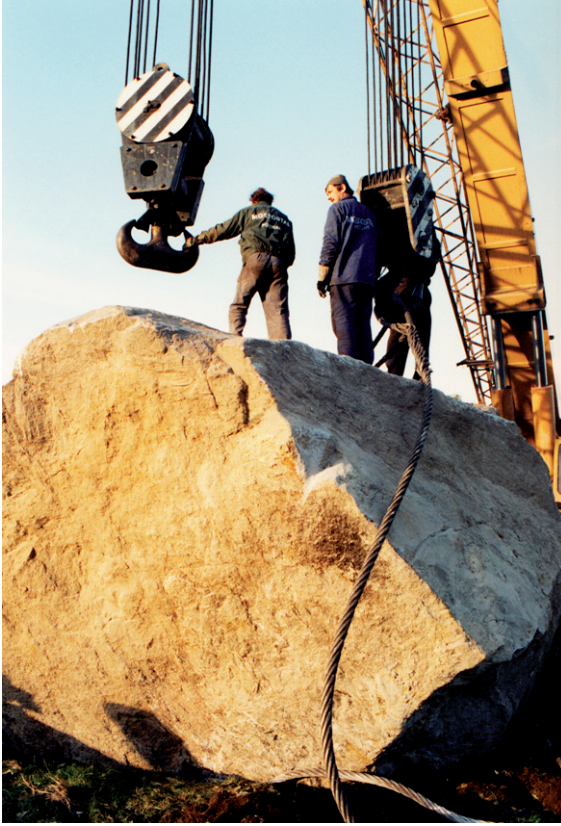
Fot. 6. Po zerwaniu liny największą trudność sprawiło założenie bezpiecznego zaczepienia. Fot. Ewa Kazimierczak-Grygiel (6 października 1994 roku)
